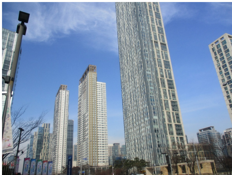
写真 28 仁川市の新都心として次々に開発が進む松島地区
