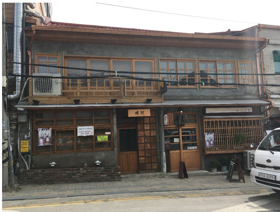
写真17 リノベーションの完成風景（2016.9）
