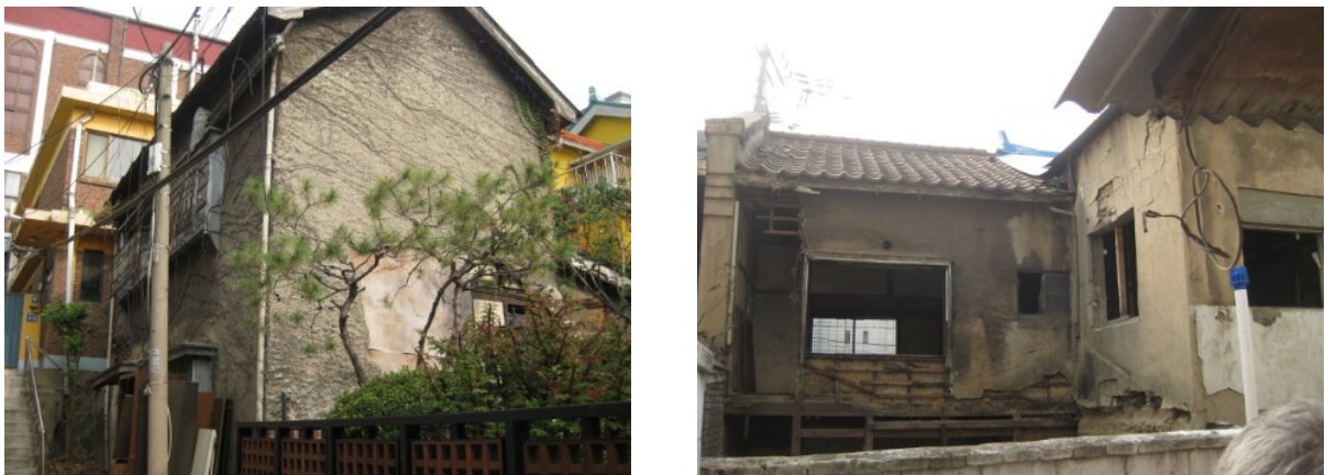
写真1 前年度に仁川市中区で調査した、空き家あるいは廃屋となって朽ちるだけの日式住宅
