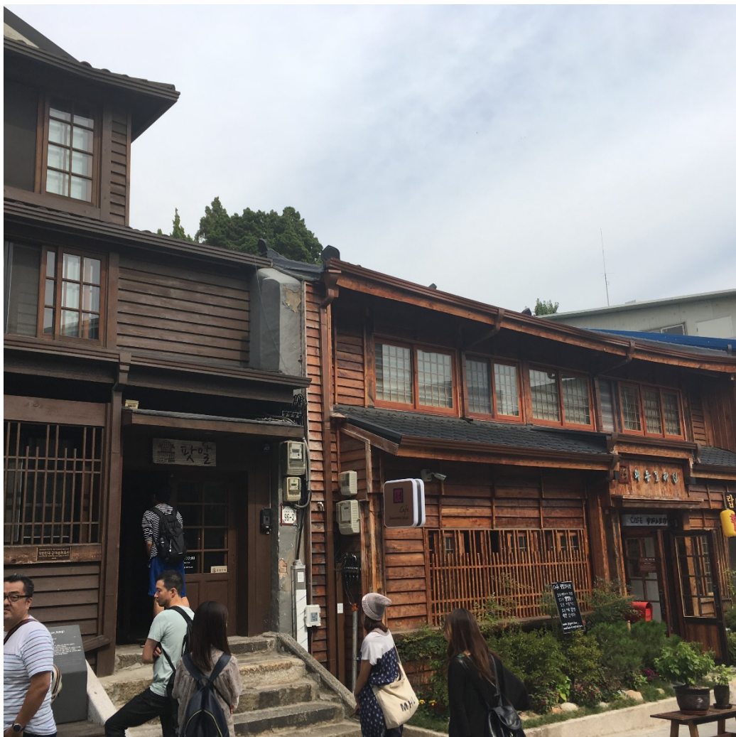
写真 12 「pot R」の隣に完成したリノベーション建築 (2016. 9)
