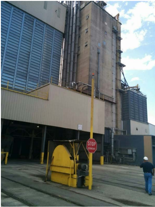
Feed Mill 工場
