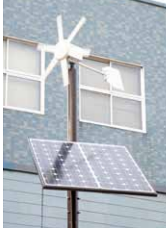
ハイブリット灯屋外照明 (太陽電池・風力発電)
