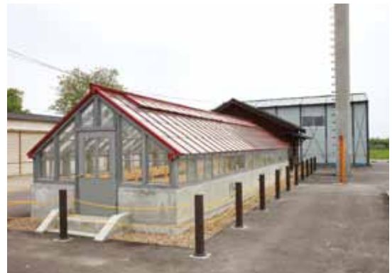
Ⓐ 旧農林省園芸試験場東北支場「ガラス温室」
