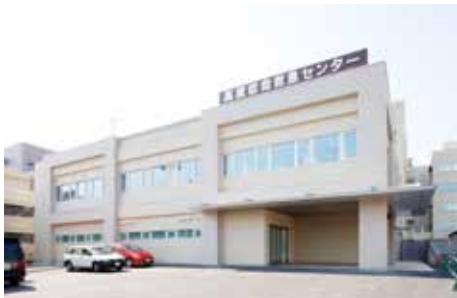
高度救命救急センター Emergency and Disaster Medical Center ⑳
