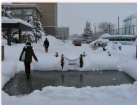
写真3 弘前大学構内に設置したヒートポンプレス地熱温度差融雪システム
