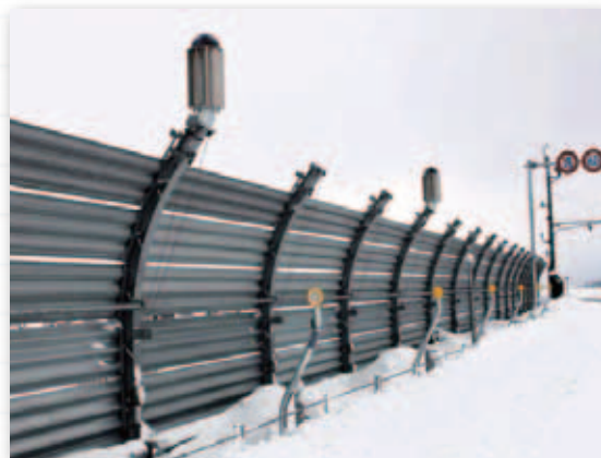
写真4 地吹雪除けの防雪柵に取り付けたローテーション型風車
