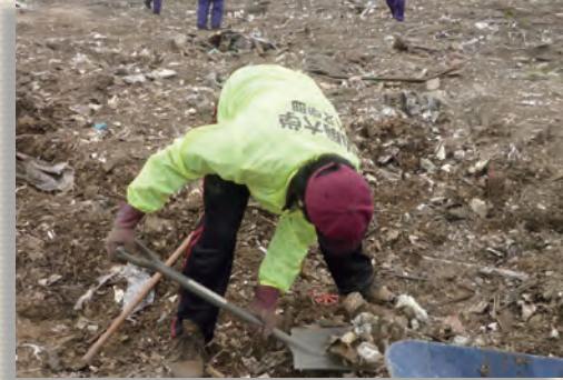
ガレキ撤去作業の様子 (2011.5.11)
