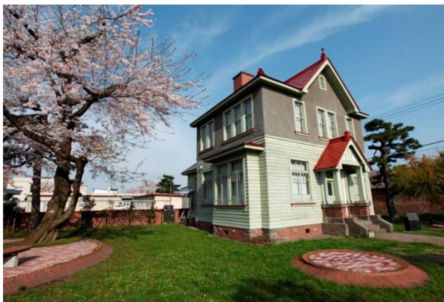
景観重要建造物に指定された旧制弘前高等学校外国人教師館
