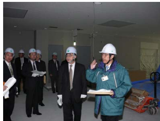
建設中の新外来棟を視察する結城次官（右から2番目）
