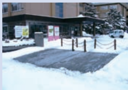
弘前大学構内に設置された地熱利用融雪システム
