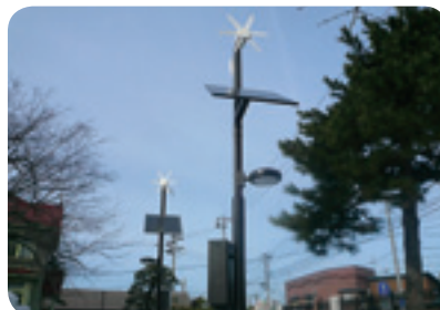
ハイブリッド灯屋外照明 (太陽電池・風力発電)
