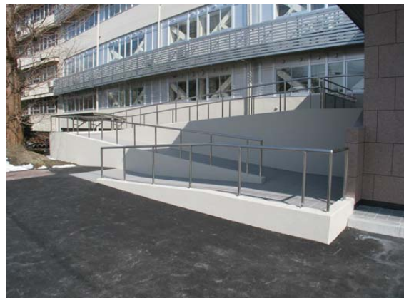
総合研究棟(臨床医学系)正面玄関脇のスロープ
