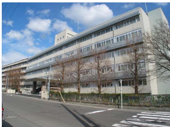
総合研究棟(臨床医学系)の外観
