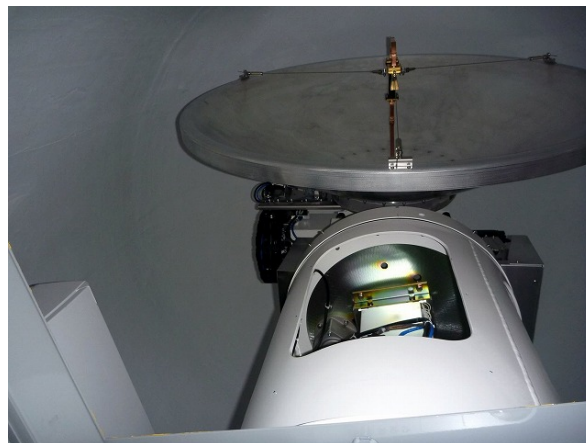
(1) ひろだい白神レーダーのアンテナ部
