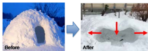
「かまくら」の崩壊事例
