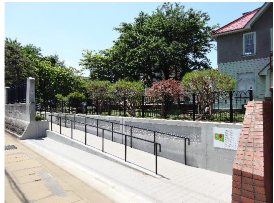
アプローチ用スロープ
