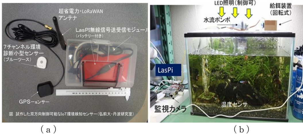
図6 超省電力型通信（LoRaWAN）を組み入れた、遠隔的双方向IoTセンサーネットワークモジュール（a）と人工養殖（水温管理、餌やり自動化）用の水槽小型モデル（b）写真
