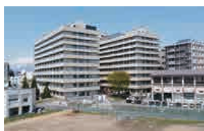
総合研究棟（臨床系）及び第二病棟
