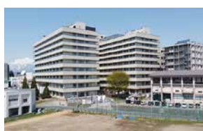
総合研究棟（臨床系）及び第二病棟
