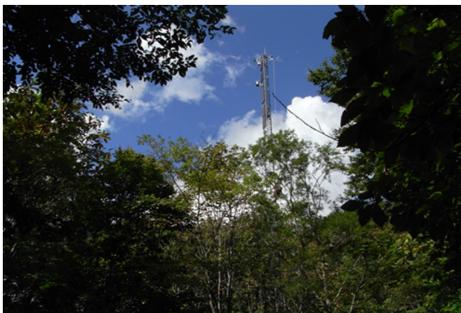
白神フラックスタワー（全高 34m：鱒ヶ沢町）
