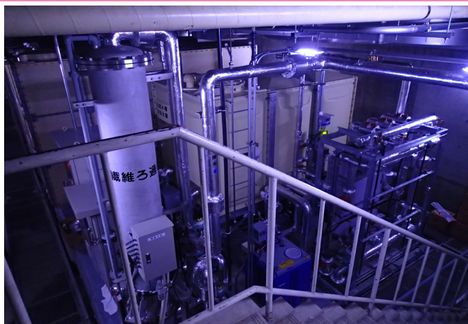
井水濾過装置
