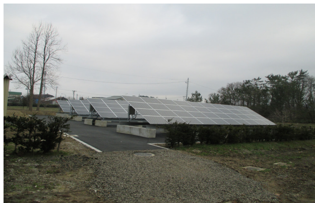
金木農場太陽光発電設備
