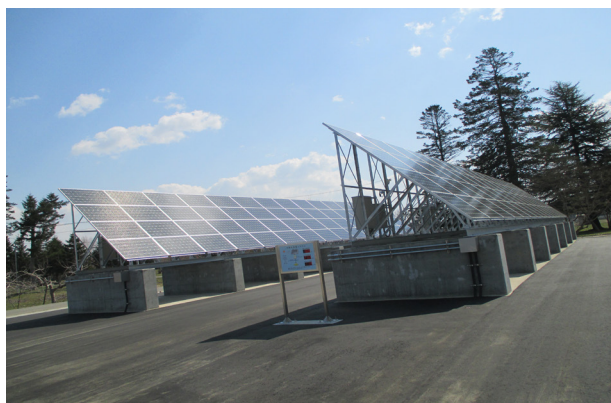
藤崎農場太陽光発電設備
