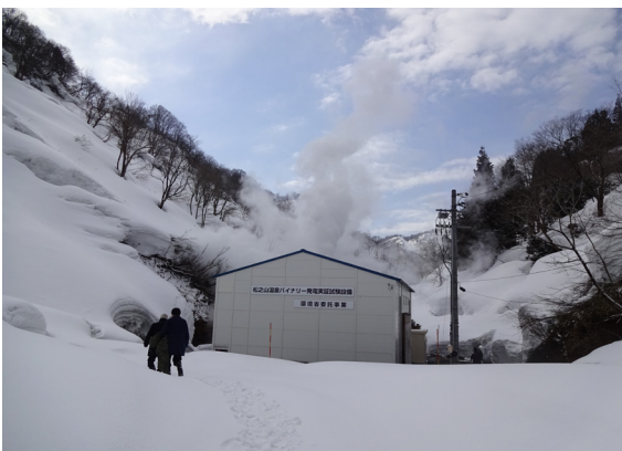
松之山温泉パイナリー発電設備
