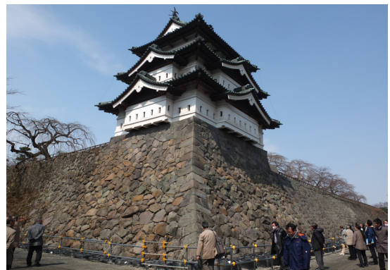
石垣の改修が進められている弘前城本丸
