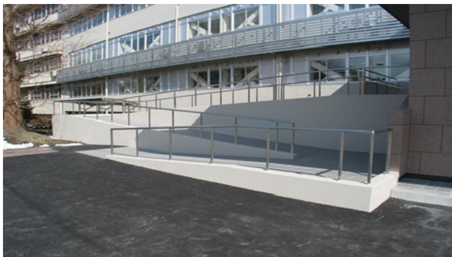
臨床研究棟正面玄関脇のスロープ
