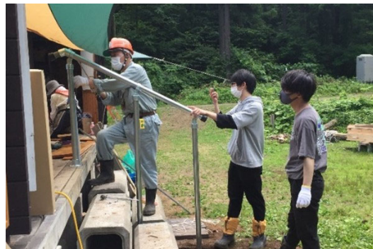
デッキ階段の手すりの調整
