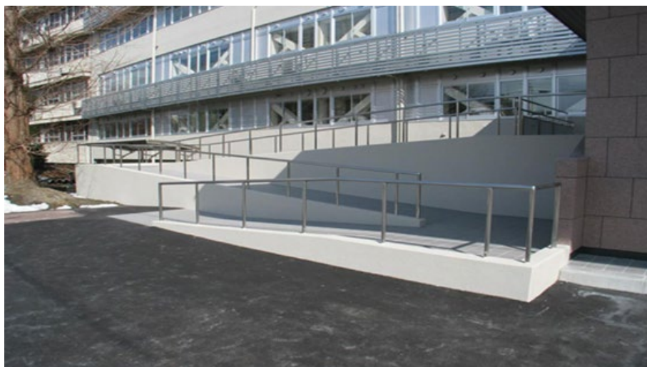
臨床研究棟正面玄関脇のスロープ
