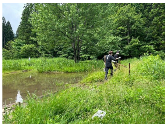
だんぶり池での安全柵設置の様子
