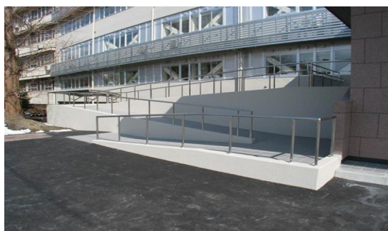
臨床研究棟正面玄関脇のスロープ
