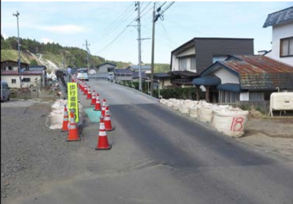
仮橋：9月2日から一般車両の通行が可能
