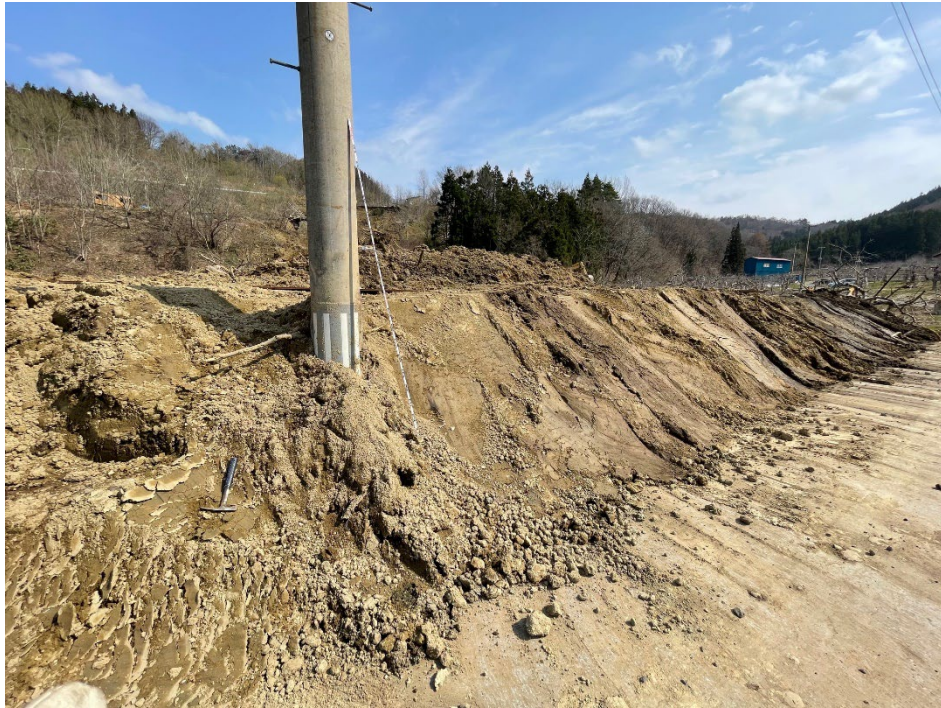
図 4 農道付近に堆積した土砂の様子
