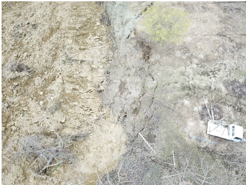
図3 図3 滑落崖上空からの写真（滑落崖背後に分布する亀裂の様子）
