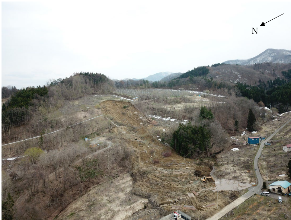
図2 調査地の斜め写真（撮影日：2025. 4. 17）
