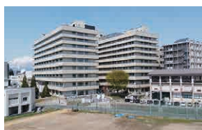
総合研究棟（臨床系）及び第二病棟
