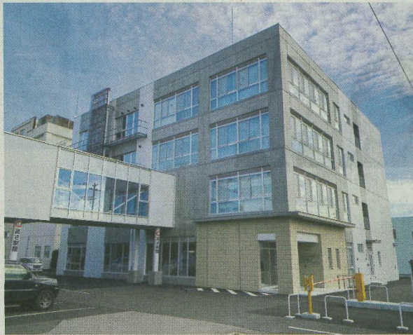
4階に研究所が設置される「グローバルWell-being総合研究棟」＝弘前大本町キャンパス
